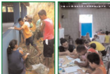
Costruzione delle strutture ed attività scolastiche a Joaquim Nabuco
